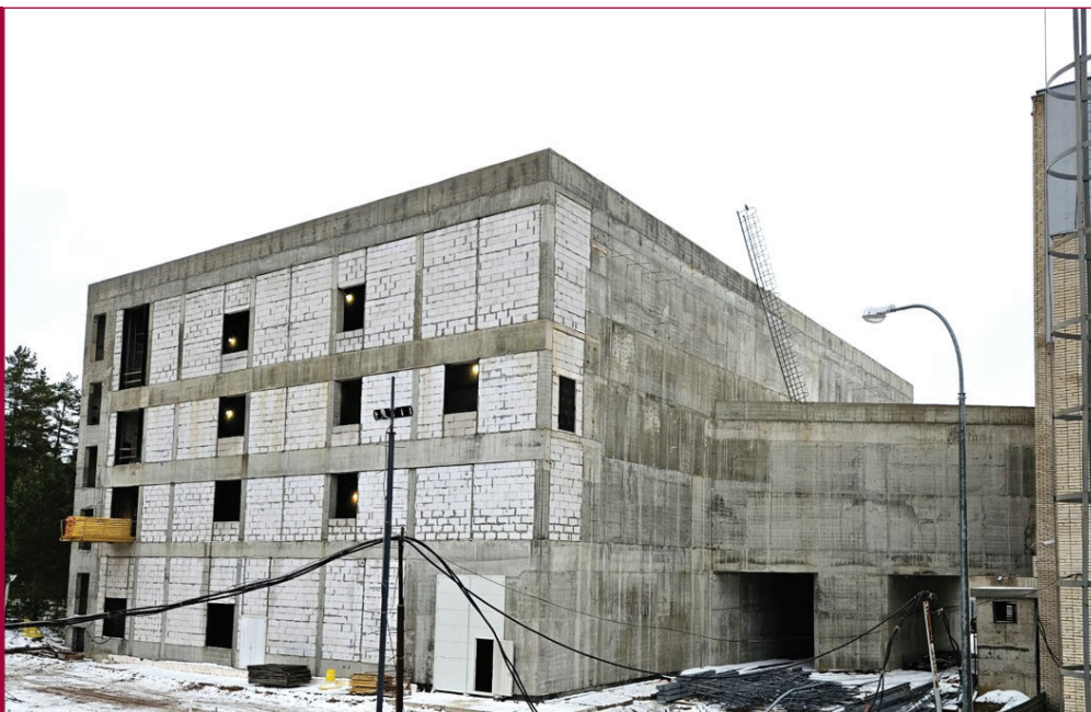
Дубна, декабрь. Строительство нового экспериментального зала комплекса У-400Р
