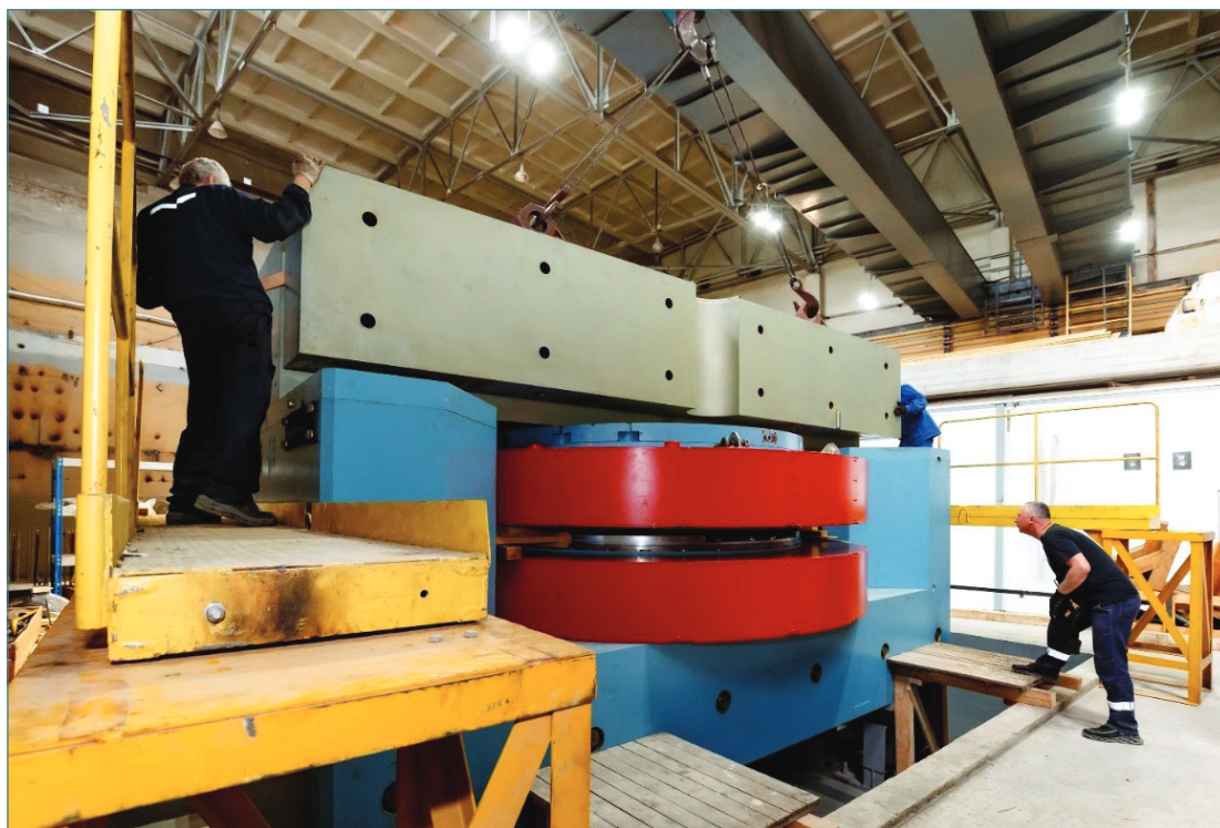
Монтаж циклотрона ДЦ-140
