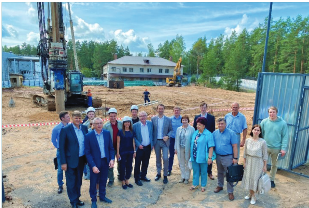
27 июля 2023 г. Вбита первая свая на строительном участке экспериментального корпуса циклотрона У-400Р
