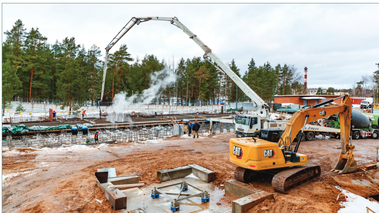
21 декабря 2023 г. Заливка первых кубометров бетона в фундамент экспериментального корпуса У-400Р
